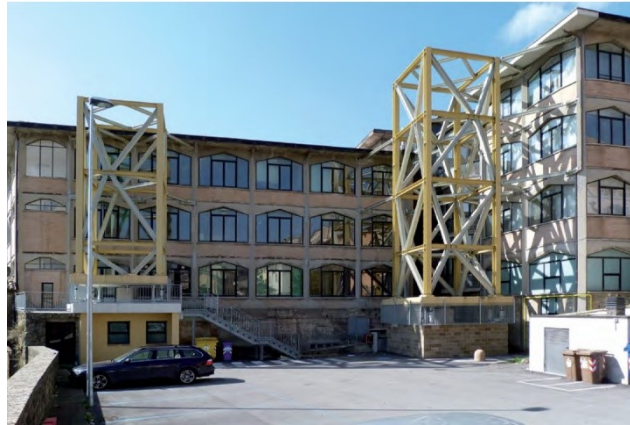
Figura 1.3 – Adeguamento del Liceo Varano di Camerino mediante “torri oscillanti dissipative” (Balducci et al [3])
