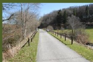
Ligne 164 - Place de la gare (Bastogne - Wiltz, Vallonia)
