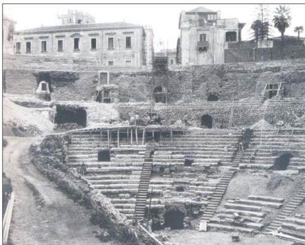
419. Lavori di liberazione del teatro, 1965.
