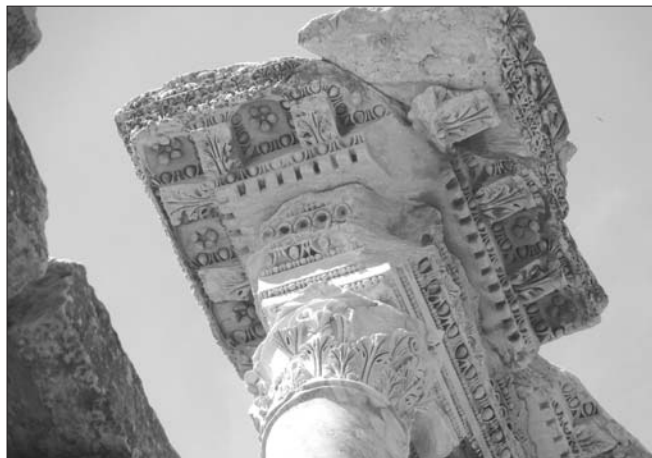
192. Particolare capitello - trabeazione della biblioteca di Celso.
