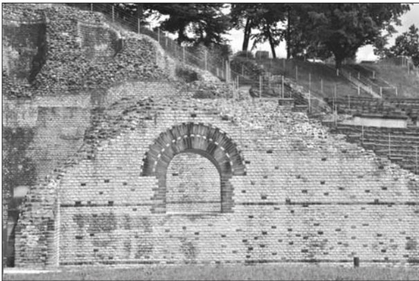
314. Augst. Vista laterale di una parete di un'aditus.
