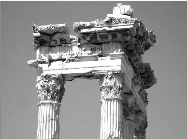
199. Pergamo. Particolare della trabeazione.
