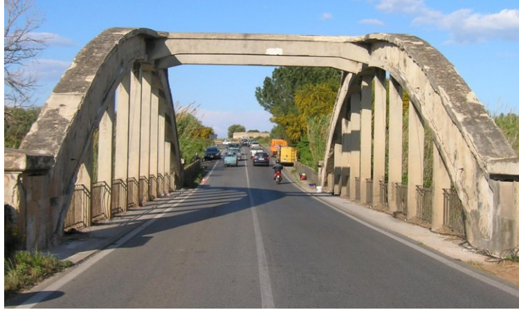
Figura 37 Ponte sul fiume Cassibile
