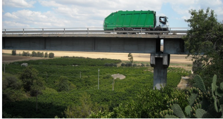
Figura 5 Ponte al km 2+149
