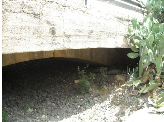
Figura 12 Ponte al km 26+249
