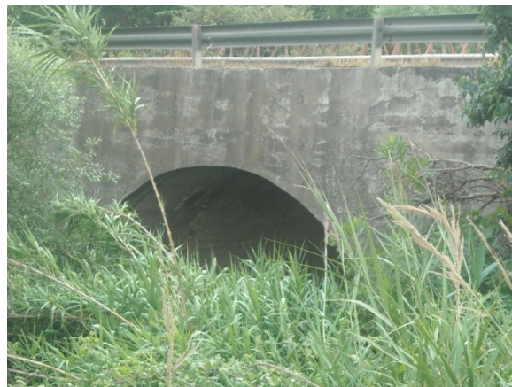
Figura 30 Ponte al km 42+554
