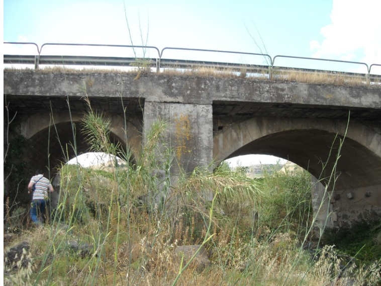
Figura 9 Ponte al km 24+685
