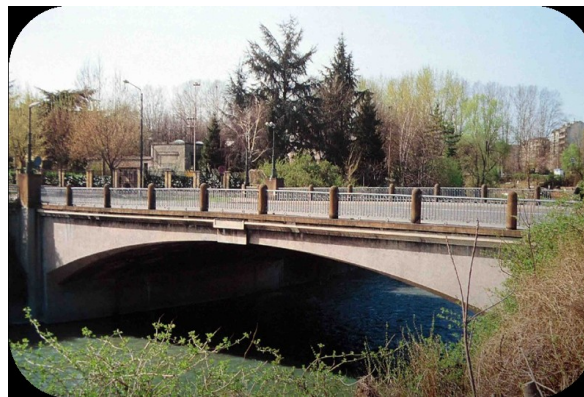
Figura16 Ponte Carlo Emanuele III, Torino [13]
