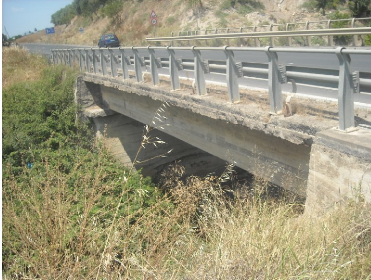
Figura 28 Ponte al km 39+916
