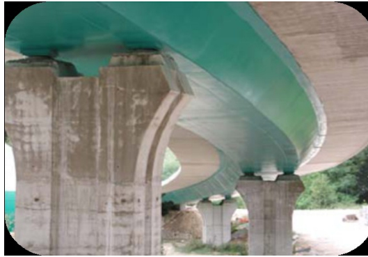
Figura19 Viadotto Fontescodella, Macerata [15]
