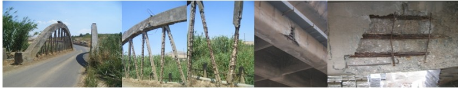
Figura 7 Ponte sulla SP 182
