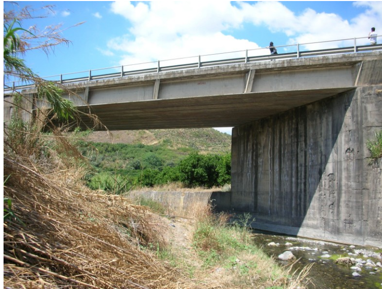
Figura 26 Ponte al km 31+720
