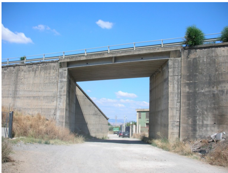
Figura 22 Ponte al km 30+619
