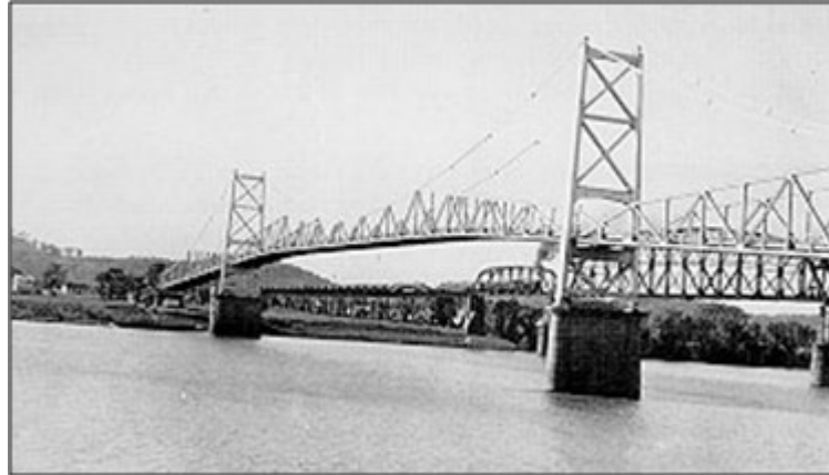
Figura 1 Point Pleasant Bridge prima del crollo [6]
