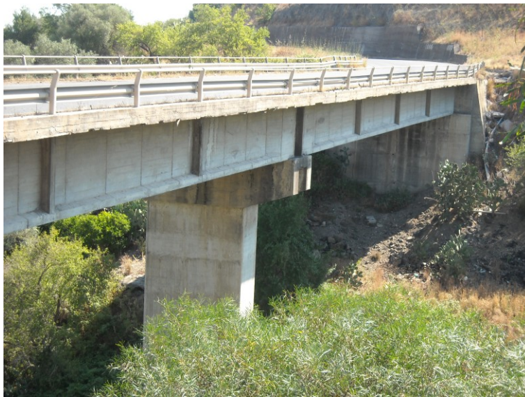
Figura 2 Ponte al km 1+700
