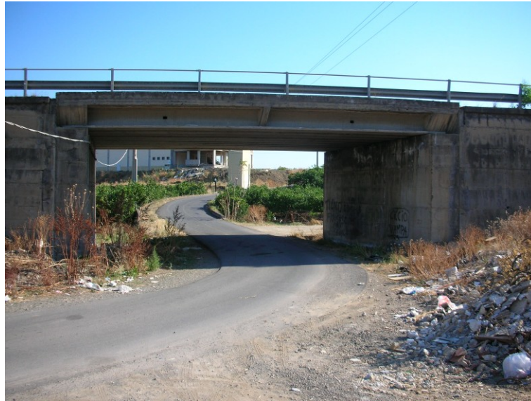
Figura 14 Ponte al km 29+070
