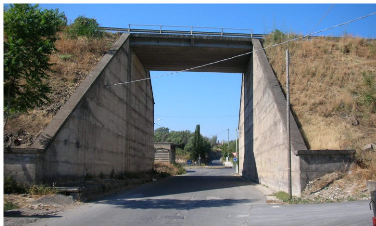
Figura 16 Ponte al km 29+529
