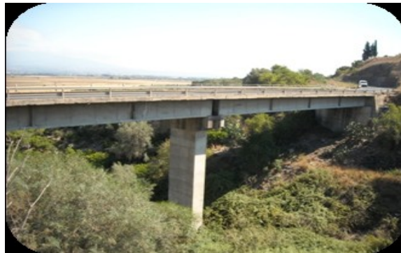
Figura18 Viadotto SS385, Siracusa
