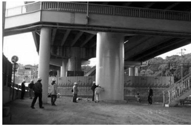
Figura 26 Esempio di incamiciatura in acciaio [26]
