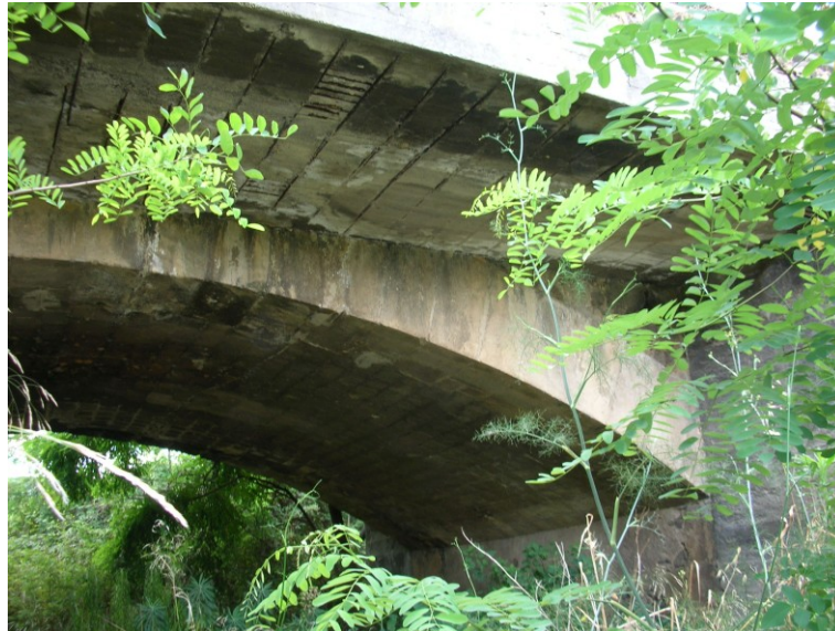
Figura 7 Ponte al km 24+606
