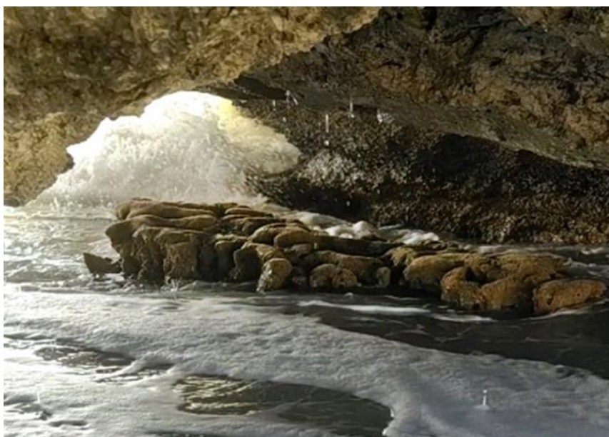
Fig. 81 – Parziale smantellamento del banco all'interno della galleria durante una mareggiata.
