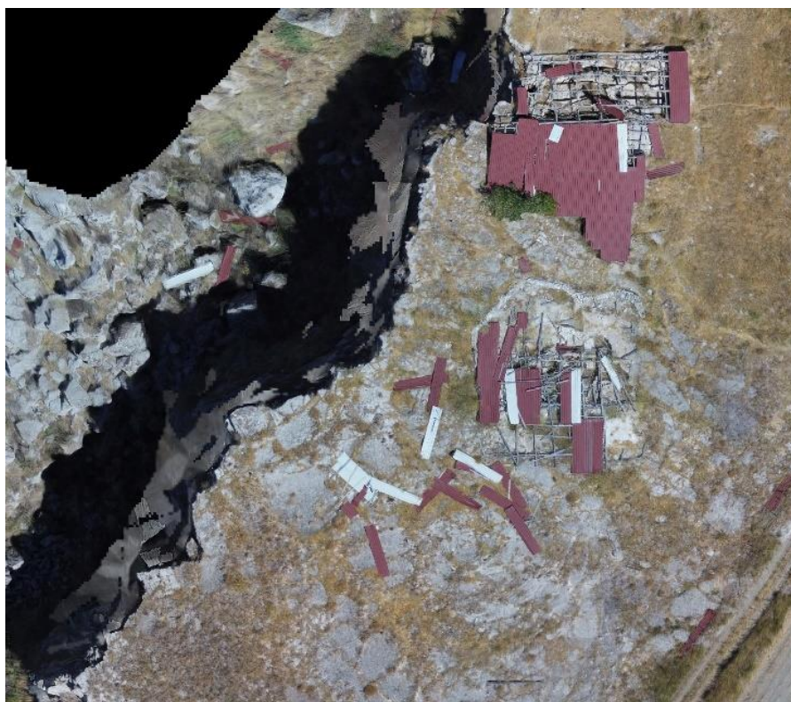
Fig. 87- La capanna Neolitica di Serra del Palco vista dall'alto. Dall'immagine si possono osservare sia le coperture metalliche divelte e collassate in gran parte sui resti archeologici, che il grado di erosione subito dalla montagna, e che rischia d'intercettare la capanna.
