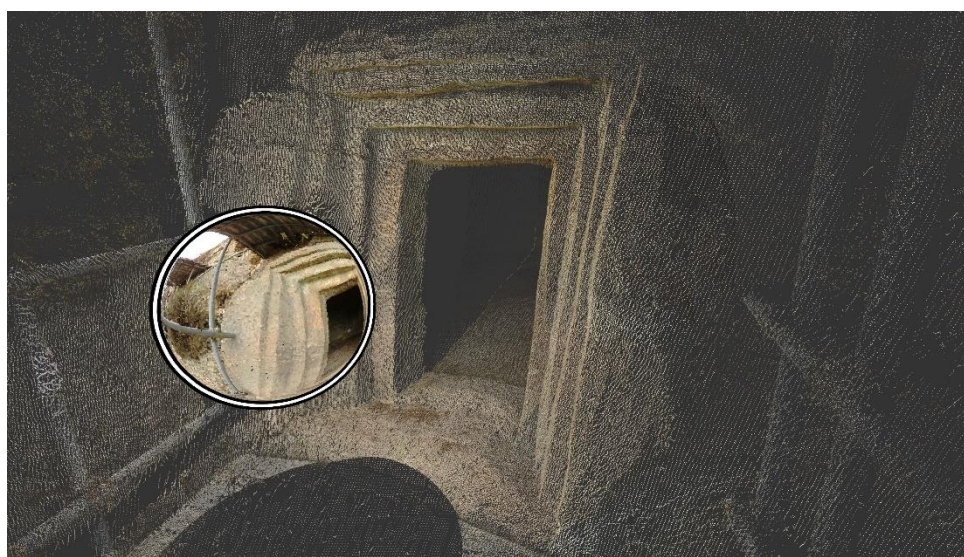
Fig. 117- Scansione tramite laser scanner della tomba a tholos a monte Campanella, ingresso.
